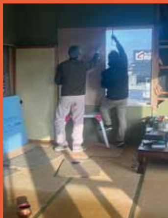
1月12日、小川が珠洲市に到着。雨風を凌ぐためにスピーディーに窓を補修する。
